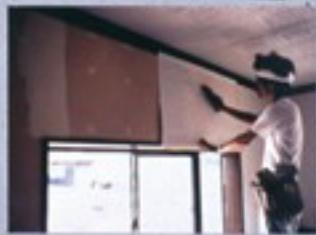
間柱の上にいきなりパワーボードをはり、室内仕上げはせっこうボードで内部に断熱材をつめて、クロスで仕上げます。
